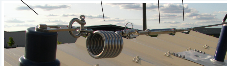
Poteau de départ Absorbeur avec témoin de chute Tendeur Cable
