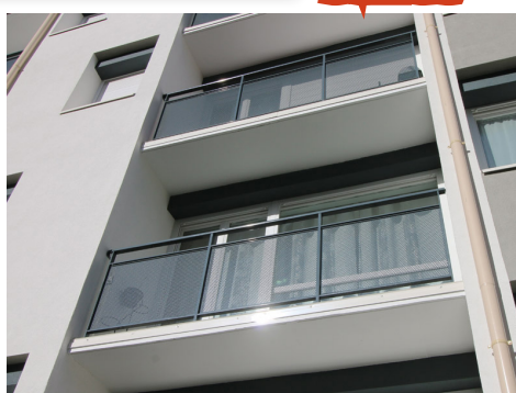
REMPLISSAGE TÔLE PERFORÉE ET DÉCOUPE LASER
