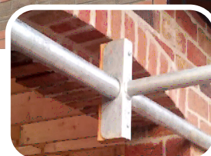
passage de baie vitrée > 3m
