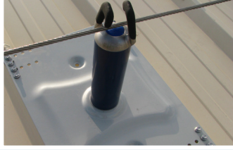
Poteau de départ Absorbeur avec témoin de chute Tendeur Cable
